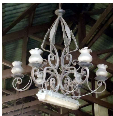
Pogled pod strop menze
