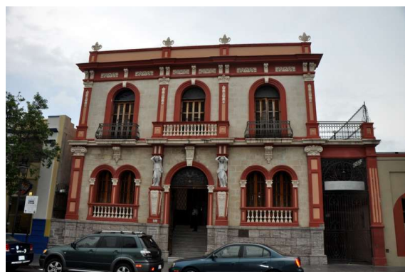
zelo stare stavbe
