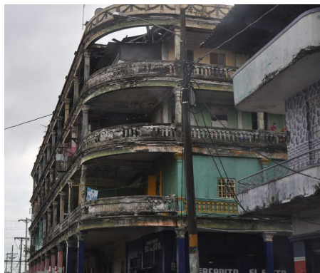
ne veš ali je bil požar al zakaj je tako vse črno ??
