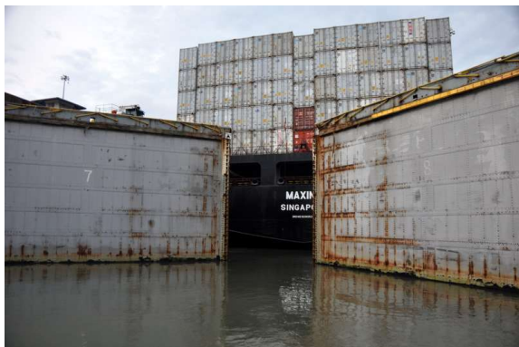
takole se pa za njo zapirajo vrata v kanalu
