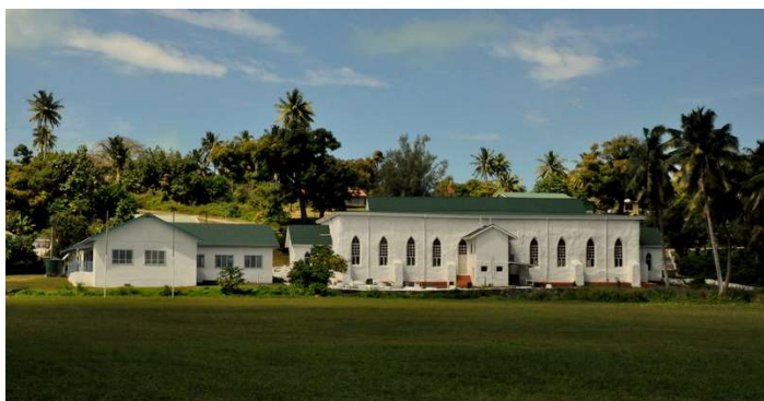
itak največja stavba je cerkev
