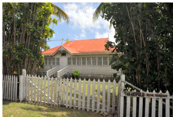
nekoč je bila lepa kraljeva rezidenca... danes pa ... očitno tudi tukaj ne znajo vzdrževati zadev, temveč enkrat naredijo in potem propada
