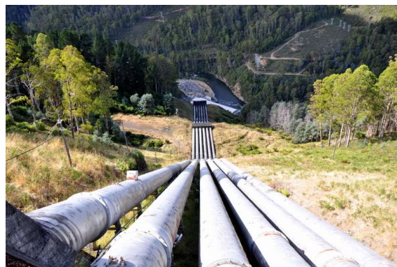
včerajšnja ogromna elektrarna - ena izmed njih na kupu
