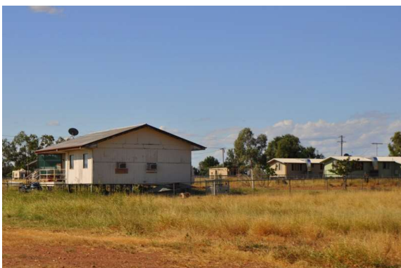
eno izmed redkih naselij: montažne hiše, dvignjene od tal - verjetno zaradi poplav, kadar je močno deževje?
