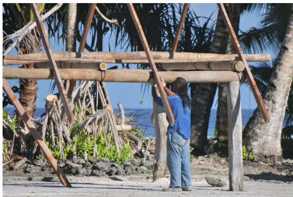
otočani pri gradnji nove hiše - menda je to timsko delo
