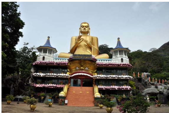
Budda zgrajen šele leta 2000, pa že sedaj beton malce poka... na žalost se danes tudi take stvari gradijo za kratek rok
