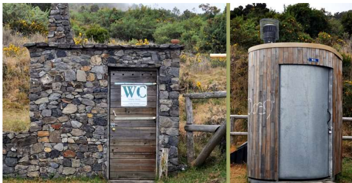
levo starodobni WC, desno novodobni v razmaku dveh metrov
