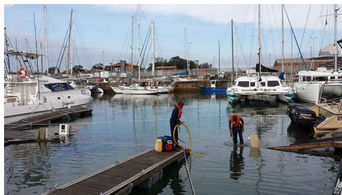
pontoni pod vodo
