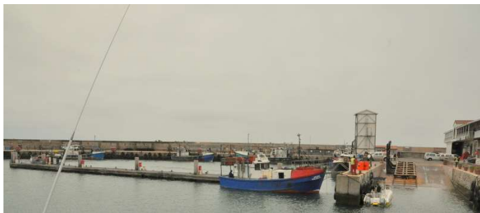
Port St Francis - ko so gradili luko so hkrati naredili še marino
