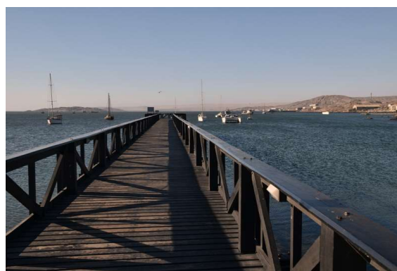
jetty je zelo dolg zaradi nizke vode in visoke plime/oseke
