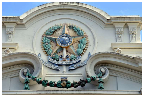
žal vlaga ne prizanaša nobenih stavbam
