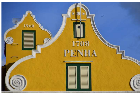
stare stavbe so vzdrževane in simpatične
