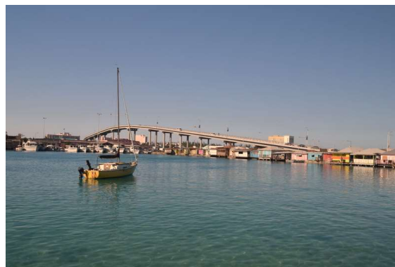
dva mosta povezujeta otoka - vsak za eno smer
