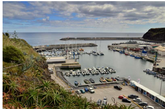
pogled na luko in marino iz obzidja....na azorih je vse nekaj venomer v hrib
