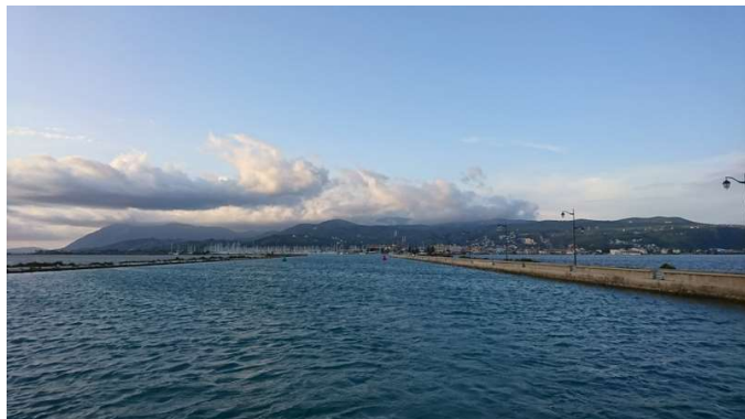
po kanalu do mostu na Lefkasu
