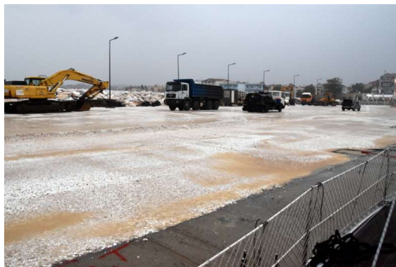
pomol s priključki je še v izgradnji, kar pomeni, da ni elektrike in vode
