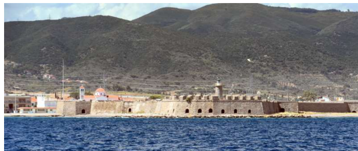
obzidje pred patraškim mostom
