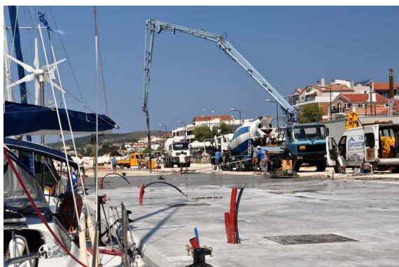
gradbinci pri betoniranju pomola so zadevo resno zastavili
