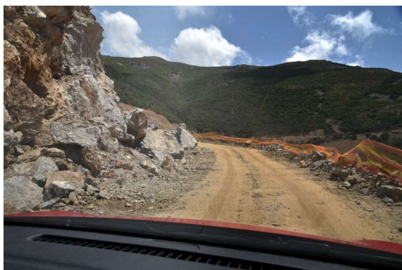
ogromno cest je uničenih zaradi dolge zime z neskončnim dežjem ... nešteti plazovi in to s kar krepkimi skalami
