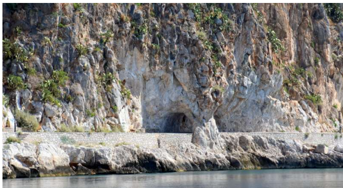
na poti do mesta Navplio se vije cesta, zanimiv tunelček ali pa podpornik?
