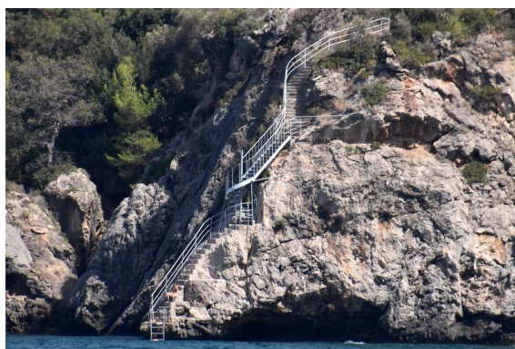
veliko vloženega dela v stopnice in ograjo samo zato, da imajo ljudje dostop do morja
