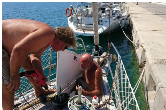
danés montaža novega sidrnega vinča....
