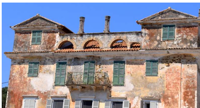
tričetr hiše so že obnovili...
