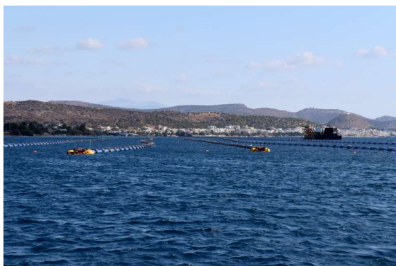
water pipe ... kaj takega pa še nisva videla v fazi izdelave
