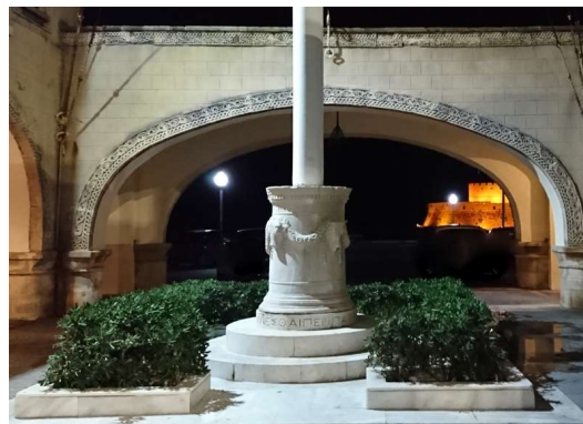
zelo dobro ohranjene stare stavbe
