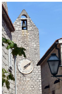
mestna ura - stolp z uro, katere mehanizem deluje še danes, je bil pa zgrajen istočasno kot loža!
