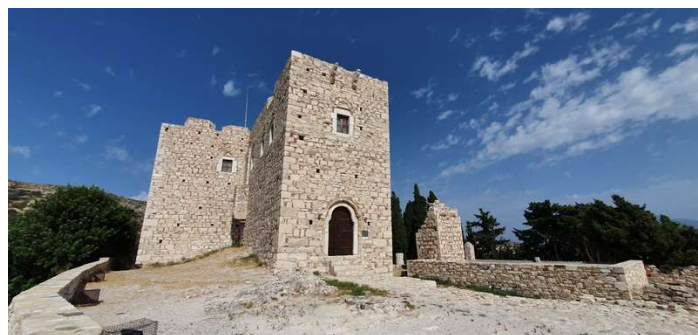
delno renovirani grad
