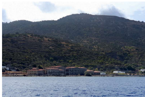
ogromen hotelski (vsaj videti je tako) kompleks v izgradnji ... ampak že zelo določoo nazaj so prenehali graditi
