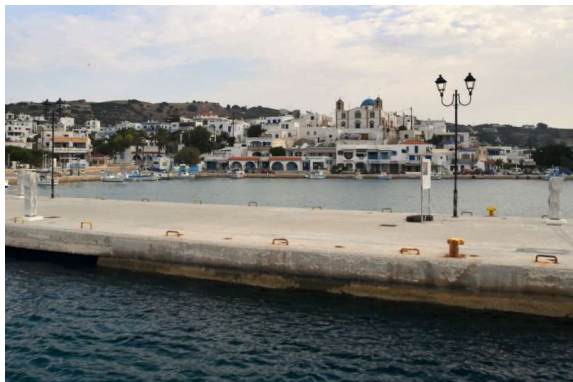
Lipsi, vasica duhov.... vsi stebri za elektriko, vodo so skrbno zaviti
