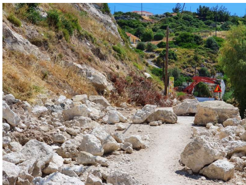
na poti do vasice je del poti težko prehoden zaradi plazu ... ampak to bodo popravljali naslednjo zimo
