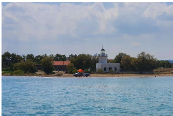
svetilnik pri vhodu v kanal
