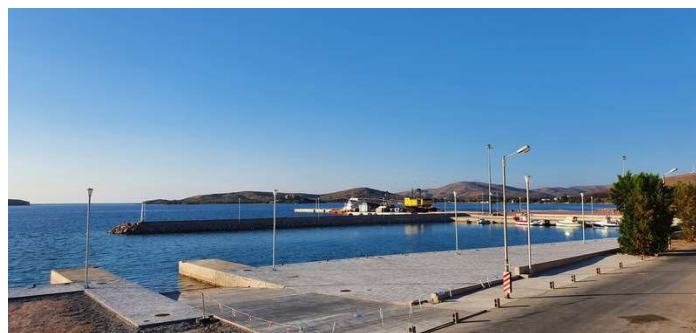
luka v kateri se ne smemo privezati; je pa delno še vedno v gradnji
