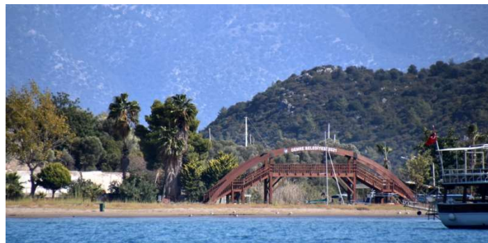
to železno konstrukcijo v guletni luki Demre so očitno postavili šele lansko leto
