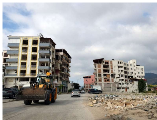
ljudje masovno podirajo poškodovane stavbe, čistijo parcele
