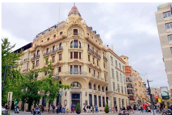
banka.... od daleč na prvi pogled kot stavba naše ljubljanske pošte v centru mesta
