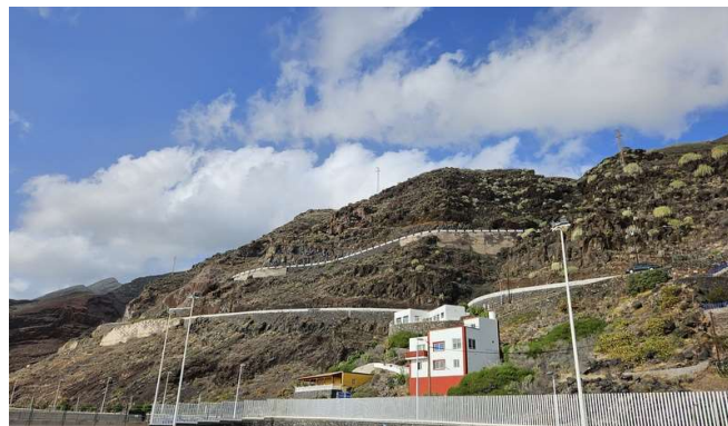
Puerto de la Estaca
