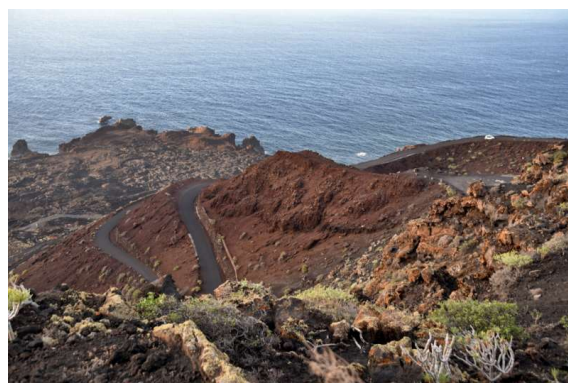
večina cest je ovinkastih in je potovalna hitrost popr.30km/h; na tej fotki pa je cesta široka samo za en avto
