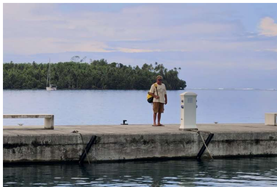
stebrički za vodo in elektriko so ... ampak ...
