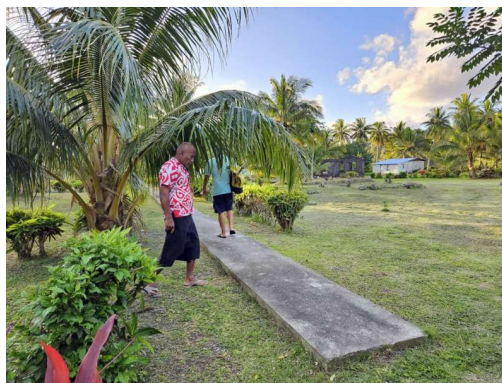
del poti iz vasi do obale je betonirane
