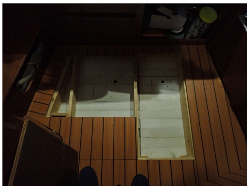
Seveda sem moral precej kombinirati, da sem pokrili cel pod, ki je sedaj večji, kot je bil pred dvigom za 12 cm. Ni pa podnic pod omaro. Tako sem pridobil dovolj lesa.
