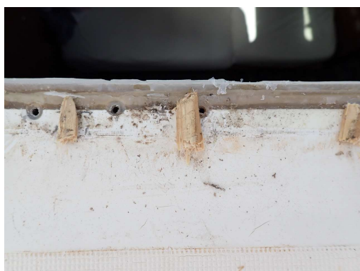
Cel kup kajlic sem zarinil vmes, ko sem rezal tesnilno maso od zunaj.
