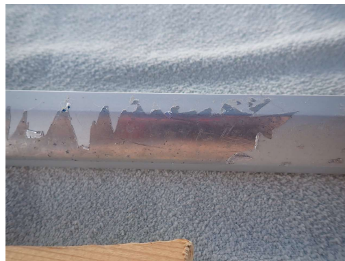
Okvir okna. 1. Delno očiščen.
