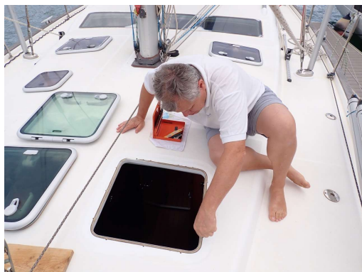
Še zadnji pregled in čiščenje pred montažo okna.
