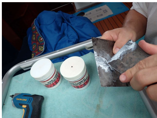
Pante sem na okvir prilimal z epoksi lepilom.
