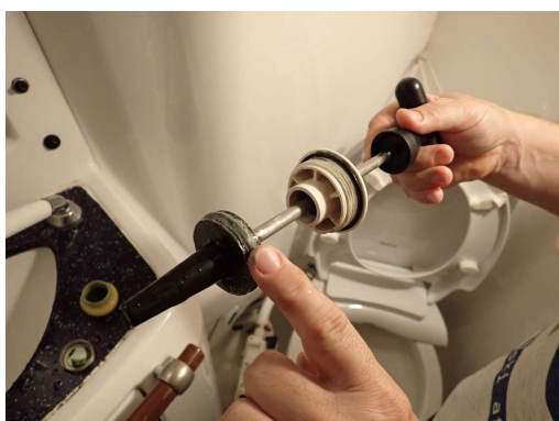
Namažem tesnilno gumico bata in os bata.
