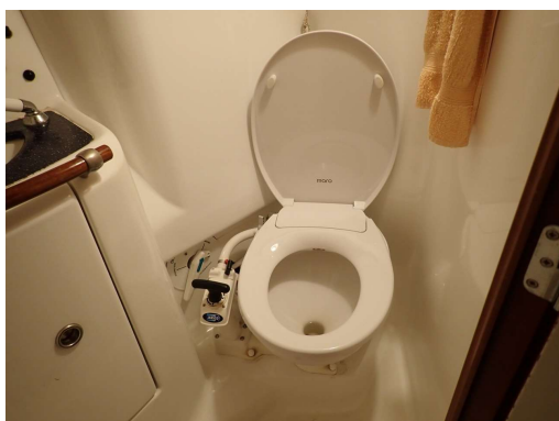
Prenovljeni CW. Nova deska, bide, ventili za regulacijo izpustov.
