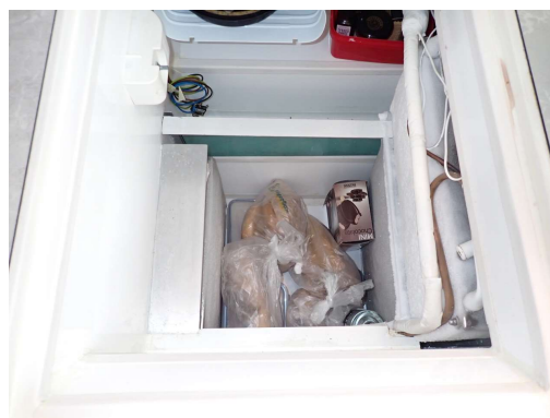
Pod pokrovom je skrinja. Levo in desno se vidi izparilnike.
