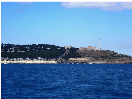
Santa Maria di Leuca. Stopnice je dal zgraditi Mussolini.
