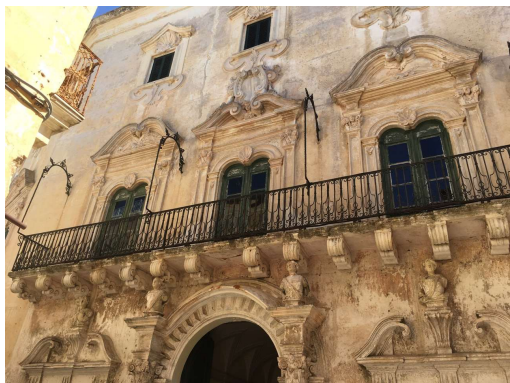
Lepa hiša. Precej kamna je zelo krhkega in ga voda izpira.
