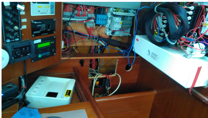
Tule se lepo vidi obstoječa okrogla luknja, kamor bo vgrajen regulator (spodaj desno)
