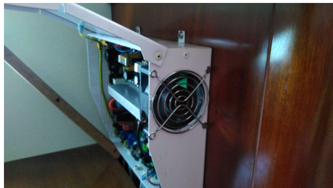
Nov ventilatorček je instaliran.
