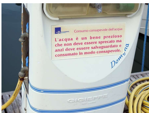
priključek za vodo in elektriko v marini
