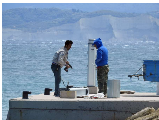
postavljanje stebričkov za elektriko in vodo
