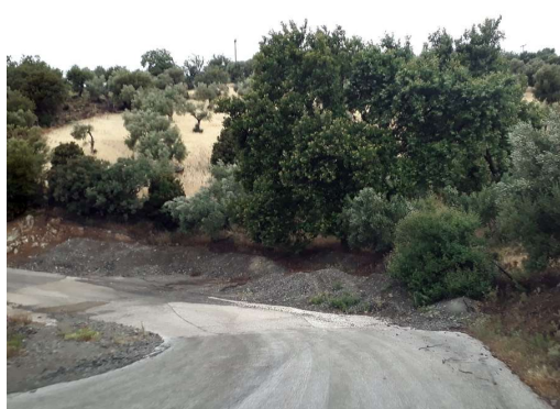
na cesti je voda in pesek od nevihte - poslastica za motoriste
