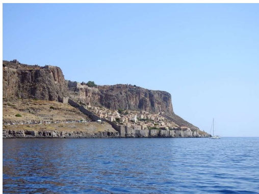
pogled na "staro" mesto
