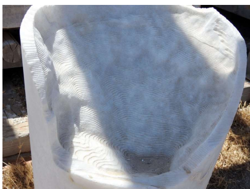
natančno porezkan manjkajoči (nadomestni) del antičnega stebra
