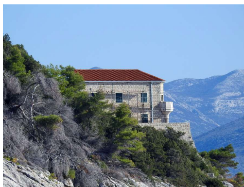
svetilničarjeva hiša na Olipi se preureja v apartmaje
