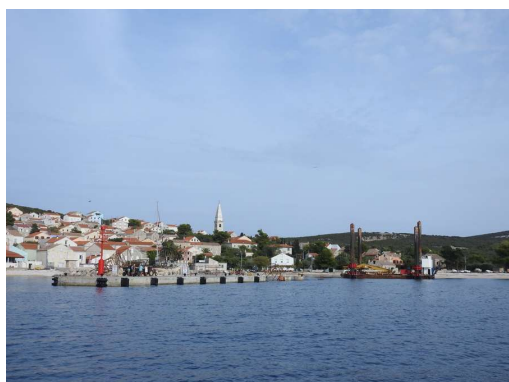
pogled na gradbišče
