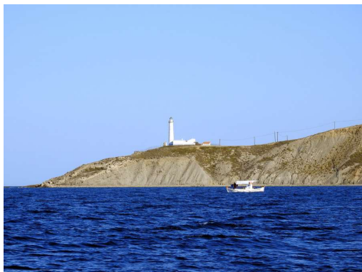
eden redkih zidanih svetilnikov v Grčiji na SV rtu Limnosa
