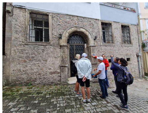
kamnit portal na starem delu hiše
