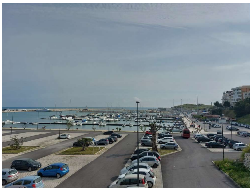
zanemarjen travnik na obali pristanišča je postal urejeno parkirišče
